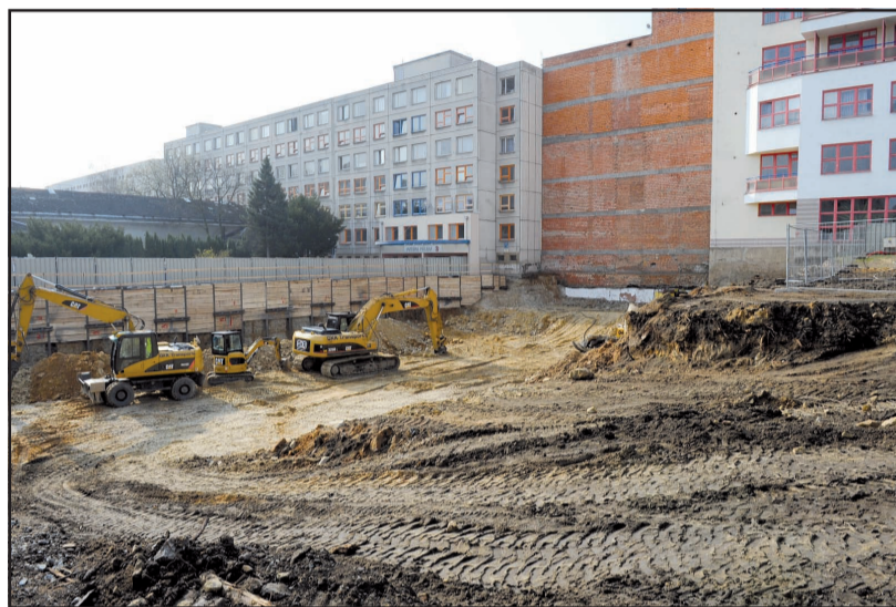
Zde bude stát nový pavilon, který bude navazovat na stávající budovu.
